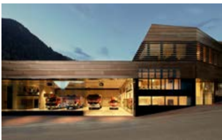
Blaulichtzentrum Ischgl + Pflegeverein Ventira Architekten
