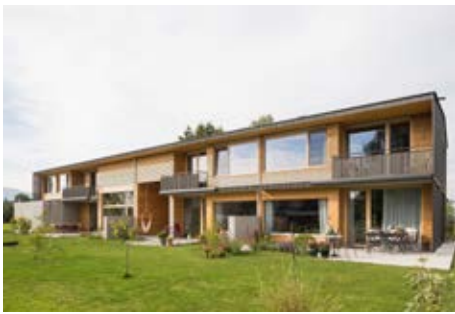
Reihenhaus LG Architekturwerkstatt Dworzak - Grabher
