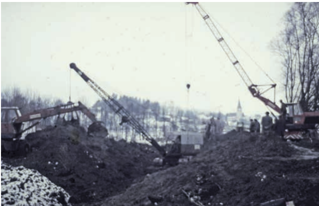
Massiver Baggereinsatz bei der Entwässerung des Timenitzer Moooses, im Hintergrund die Kirche von Timenitz, 1970er Jahre (Quelle: Familie Karnitschnig, Sillehof)
